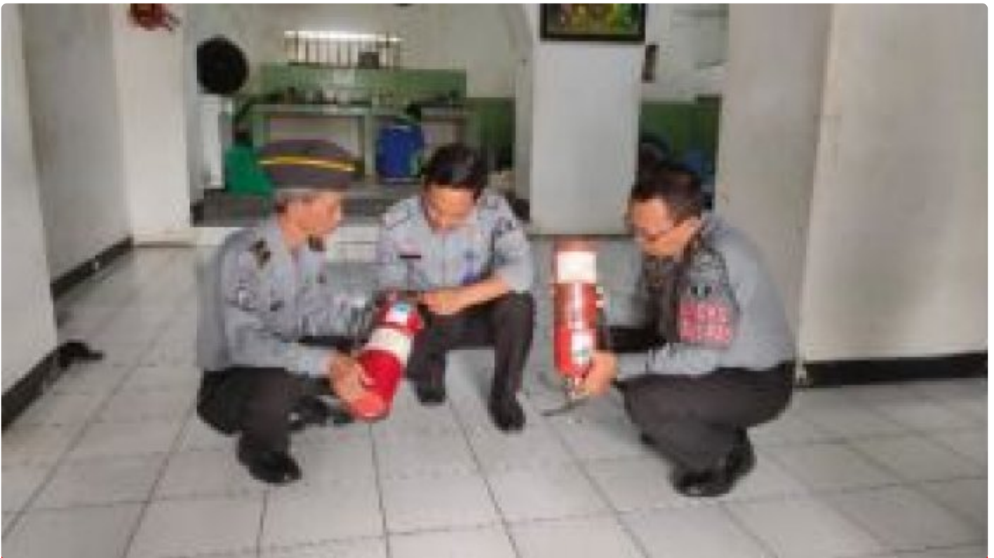
Petugas Lapas Ambarawa Lakukan Pengecekan APAR Antisipasi Kebakaran
